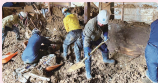
土砂の 撤去作業の 様子
