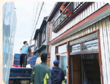
公費解体に向けて災害ゴミを搬出する様子
