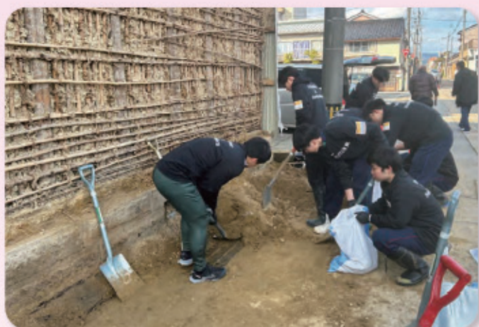
崩れた土壁を土嚢袋につめる活動中
