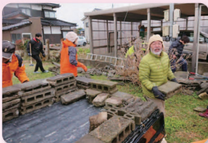
傾いたブロック塀を解体・搬出している様子
