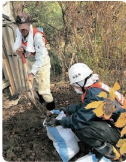
氾濫した土砂を民家の庭先から搬出するボランティア (令和元年11月24日・長野市にて)
